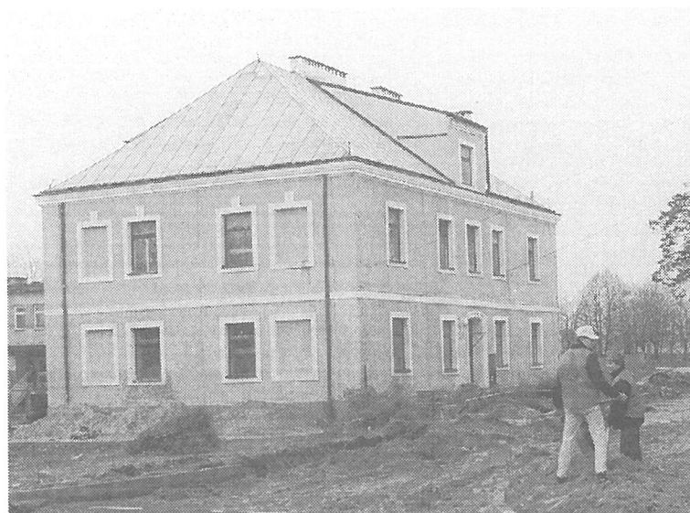
Budynek byłego przedszkola Nr 3 - dojazd - 20.XI.1996 r.
