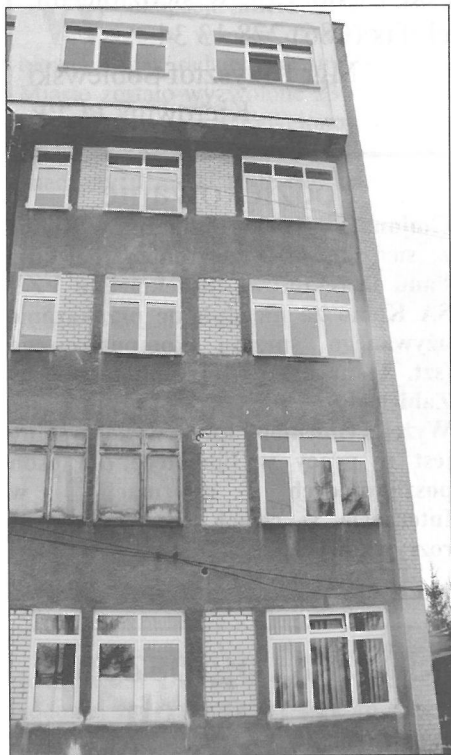
Długi Szpitala budynek
