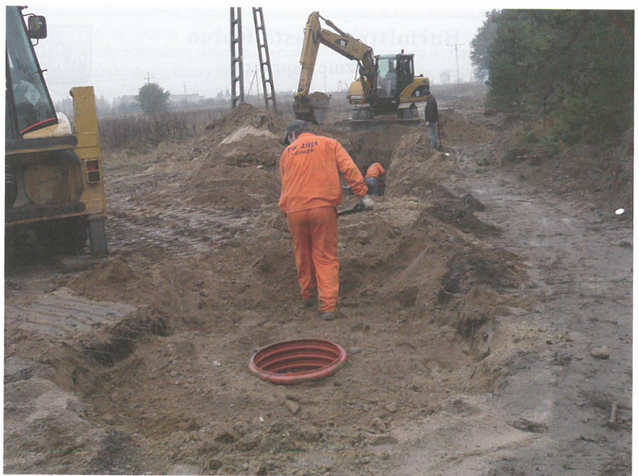
Rozpoczęte prace ziemne
