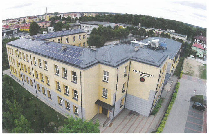
4. Szkoła Podstawowa nr 1 im. Tadeusza Kościuszki w Kolnie - instalacja o mocy 40kW
