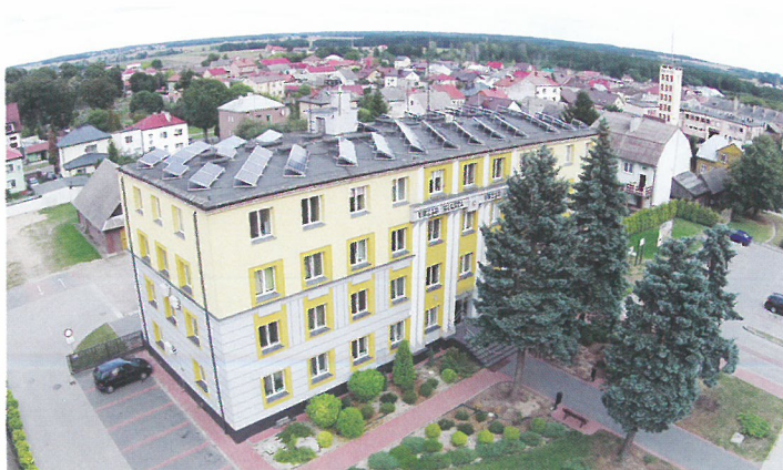
1. Urząd Miasta Kolno – instalacja o mocy 40kW
