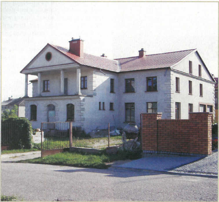
Obecny stan budynku
