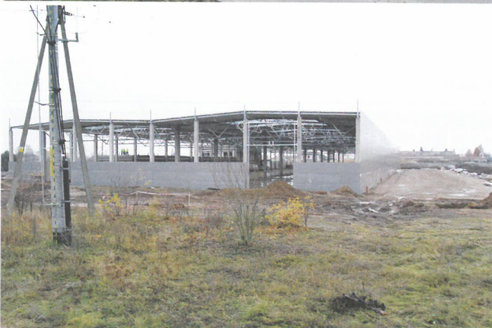
Budowa zakładu Domczar. Stan z listopada br.
