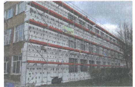
Na zdjęciu: budynek SP 2
