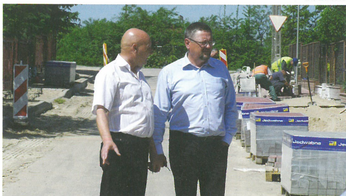
Od lewej kierownik robót remontowych Andrzej Piłat z burmistrzem Kolna Andrzejem Dudą
