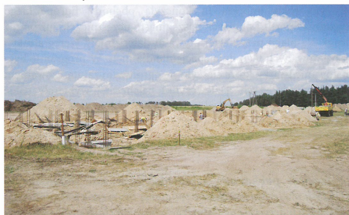
Budowa zakładu przebiega szybko i sprawnie. Na zlecenie inwestora zakład buduje kolneńska firma KOLBUD.
