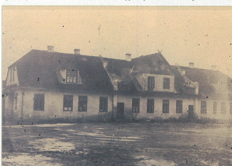
■ Budynek ochronki z początku XX wieku
