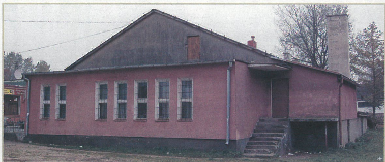
■ Budynek przyszłego GOK-u
