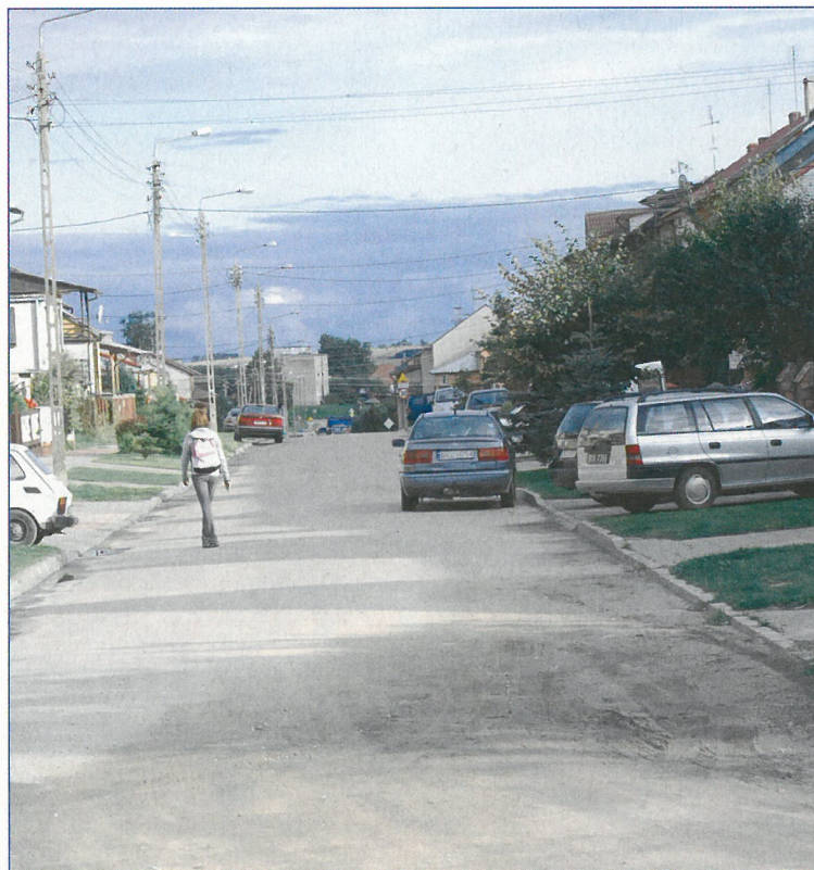
Ulica Krupki w Kolnie. Po jej obu stronach ma przebiegać kanalizacja
