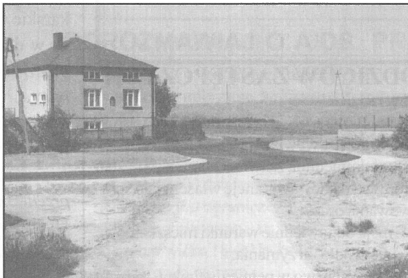
Nowa droga dojazdowa do Zespołu Szkół Samorządowych w Zabielu
