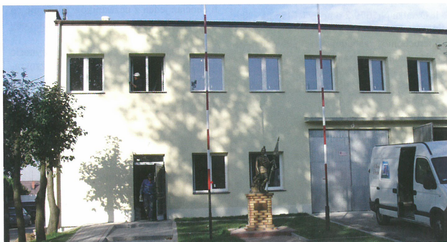
Dobiegają końca prace przy docieplaniu budynku GOK.
